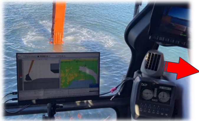
浚渫施工状況
